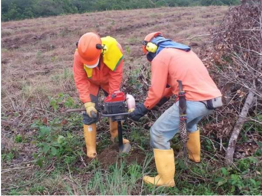
Figura 9 Preparación del terreno con taladro de hoyado
