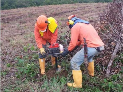
Figura 9 Preparación del terreno con taladro de hoyado
